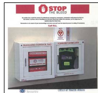
AEDとならんで設置されているタニケット
