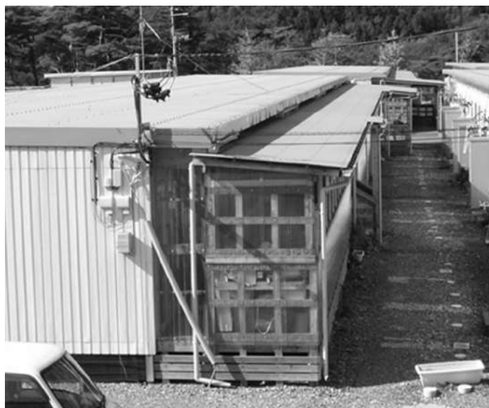
図2 建設された仮設住宅の写真（東日本大震災）
